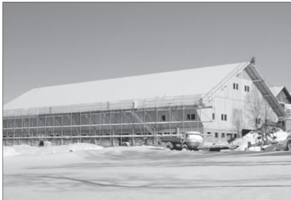
Noch vor dem ersten Schnee konnte die Scheune in Le Fuet ob Tavannes eingedeckt werden.
